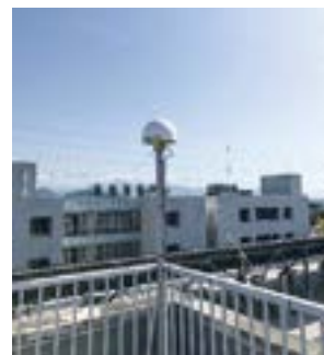
GNSS連続観測点沼津局 (電子制御工学科棟屋上)
